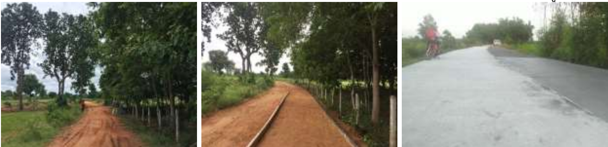
45.โครงการก่อสร้างถนน คสล. รหัสสายทาง นม.ถ.131-18 สายบ้าน ช่อพัฒนา -ทิศตะวันตกบ้าน หมู่ที่ 8
