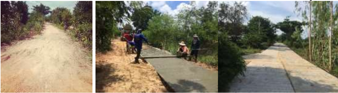
33.โครงการก่อสร้างถนน คสล.สายบ้านนายฉลองถึงถนนลาดยาง บ้านช่อระกา หมู่ที่ 1
