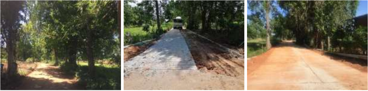
38.โครงการก่อสร้างถนน คสล. สายสี่แยกบ้านนายมาลัยถึงแยกบ้านหนองแวม หมู่ที่ 6
