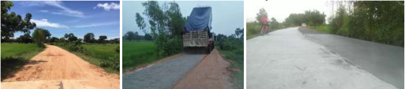
34.โครงการก่อสร้างถนน คสล.สายหน้าโรงเรียน บ้านม่วงถึงโนนขี้ต้อน หมู่ที่ 2
