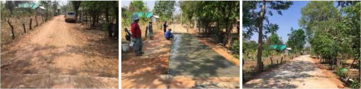
39.โครงการก่อสร้างถนน คสล.สายตะวันตกเมรุถึงโนนขี้ตุน หมู่ที่ 7
