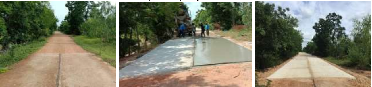
40.โครงการก่อสร้าง ถนน คสล. สำหรับให้น้ำล้นผ่าน (ฝายกั้นน้ำ) บริเวณประปาหมู่บ้าน หมู่ที่ 9
