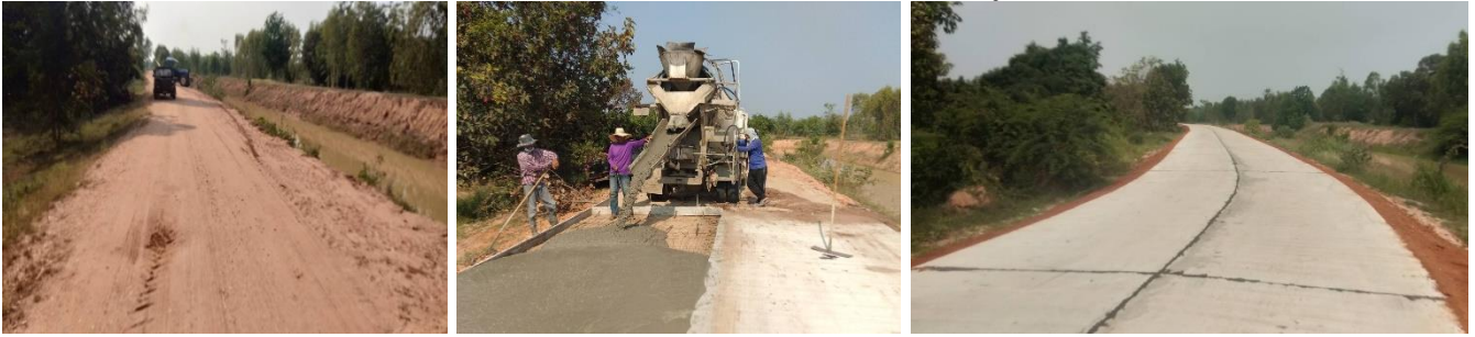
32.โครงการก่อสร้างถนน คสล.สายหน้าโรงเรียน บ้านม่วงถึงโนนขี้ตุน หมู่ที่ 2
