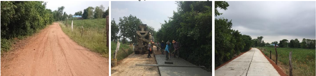
34.โครงการก่อสร้างถนน คสล.สายตะวันตกเมรุถึงโนนขี้ตุน หมู่ที่ 7
