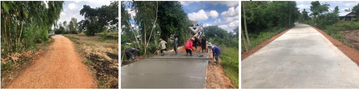
37.โครงการก่อสร้างถนน คสล. รหัสสายทาง นม.ถ.131-13สายแยกคลองอีสานเขียว-บ้านโนนสะอาด หมู่ที่ 4
