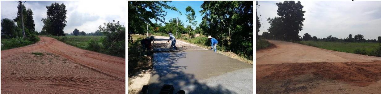
38.โครงการก่อสร้างถนน คสล. รหัสสายทาง นม.ถ.131-15 สายบ้านดอนยาว-ดอนลำดวน หมู่ที่ 5
