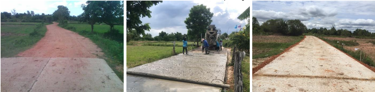
33.โครงการก่อสร้างถนน คสล.จากแยกบ้านนายจรูญ ถึงแยกไปหนองรัง หมู่ที่ 8
