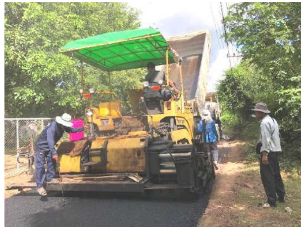
21.โครงการปรับปรุงผิวถนนคสล. โดยปูยางแอสฟัลต์ติกทับถนน คสล. เดิม รหัสทาง นม.ถ. 131-05 บ้านช่อพัฒนา – บ้านหนองรัง หมู่ที่ 8 (ข้อบัญญัติ)
