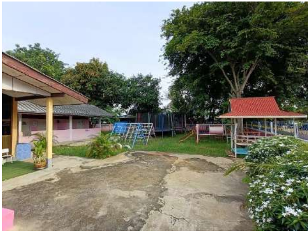
23.โครงการก่อสร้างอาคารเรียน ศพด.บ้านโนนเพ็ด (อุดหนุน)
