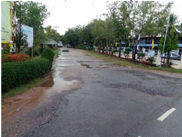
20.โครงการปรับปรุงผิวถนนคสล. โดยปูยางแอสฟัลต์ติกทับถนน คสล. เดิม รหัสทาง นม.ถ. 131-03 ซอระกา-โนนเพ็ด หมู่ที่ 7 (ข้อบัญญัติ)
