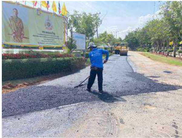
20.โครงการปรับปรุงผิวถนนคสล. โดยปูยางแอสฟัลต์ติกทับถนน คสล. เดิม รหัสทาง นม.ถ. 131-03 ซอระกา-โนนเพ็ด หมู่ที่ 7 (ข้อบัญญัติ)
