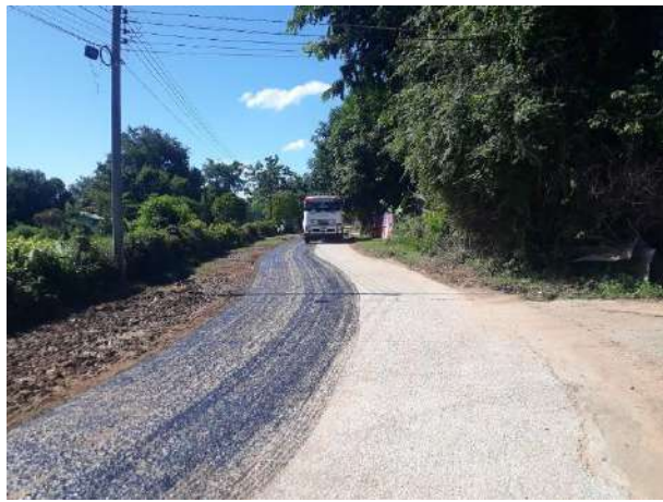
9.โครงการปรับปรุงผิวถนนคสล. โดยปูยางแอสฟัลต์ติกทับ ถนน คสล. เดิม รหัสทาง นม.ถ. 131-05 บ้านช่อพัฒนา – บ้านหนองรัง หมู่ที่ 8 (สะสม)
