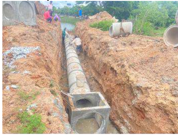
17.โครงการวางท่อระบายน้ำระบบพร้อมประตูเปิด-ปิด 2 จุด หมู่ที่ 3 (ข้อบัญญัติ)
