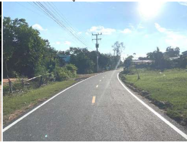
9.โครงการปรับปรุงผิวถนนคสล. โดยปูยางแอสฟัลต์ติกทับ ถนน คสล. เดิม รหัสทาง นม.ถ. 131-05 บ้านช่อพัฒนา – บ้านหนองรัง หมู่ที่ 8 (สะสม)
