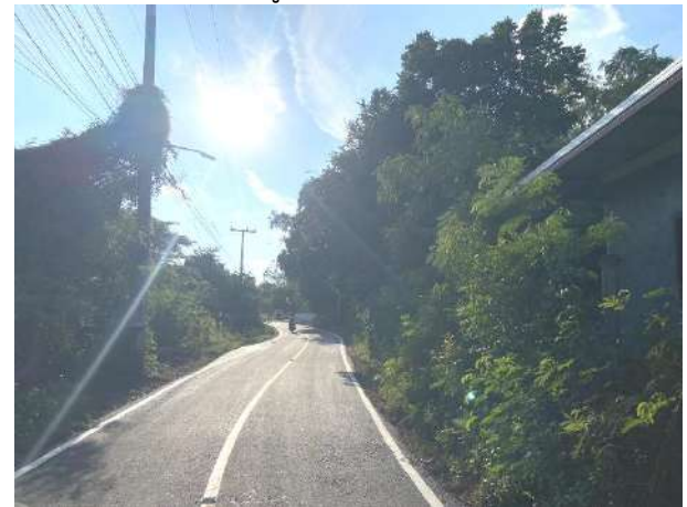
21.โครงการปรับปรุงผิวถนนคสล. โดยปูยางแอสฟัลต์ติกทับถนน คสล. เดิม รหัสทาง นม.ถ. 131-05 บ้านช่อพัฒนา – บ้านหนองรัง หมู่ที่ 8 (ข้อบัญญัติ)
