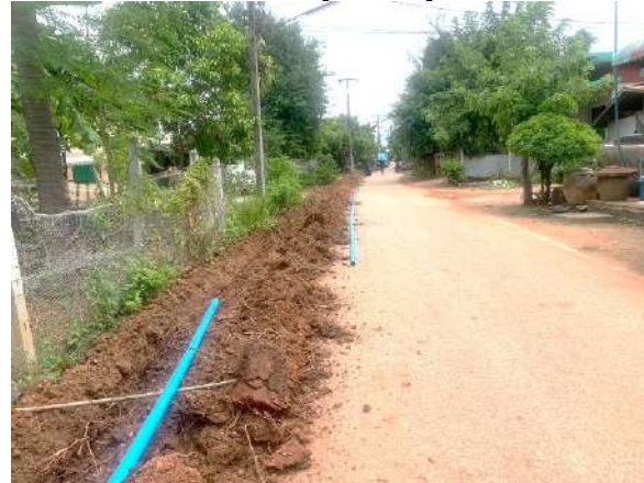
10.โครงการวางท่อเมนระบบประปาหมู่บ้านทั้งระบบ เชื่อมต่อกับระบบประปาหมู่บ้าน หมู่ที่ 3
